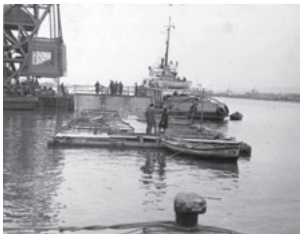
Момент от строителството на поредното ново корабно място в Пристанище Бургас с участието на 100-тонния плаващ кран „Херкулес“ и портовия влекач „Венера“. Снимката е направена след 1970 г. Източник: Дигитален архив на „Морски вестник“.
