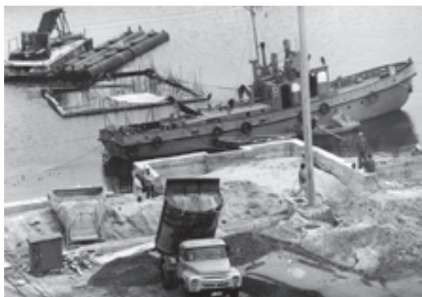
Момент от строителството на Фериботния пристанищен комплекс край Варна, 1975 г. Източник: Държавен архив – Варна.
