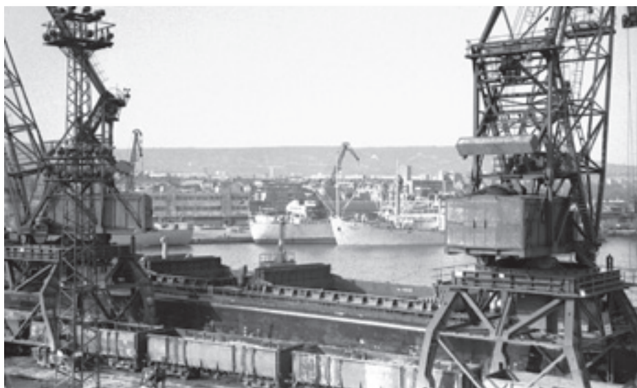
Кейовата механизация на Пристанище Варна позволява претоварването на насипните товари от хамбарите на пристигналите кораби директно на жп вагони. Източник: Дигитален архив на „Морски вестник“.
