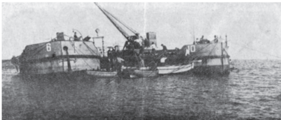
Поставяне на първите блокове в морето за новостроящото се пристанище във Василико. Източник: списание „Морски сговор“, 1929 г.
