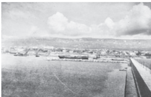
Панорама от строителството на Пристанище Варна. Източник: Държавен архив – Варна.
