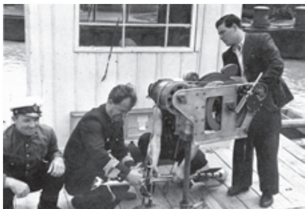
Началникът на Пристанище Охрид Л. Ив. Тодоров (кленалият с униформа, без шапка) ремонтира пристанищно съоръжение. Източник: Държавен архив – Варна.
