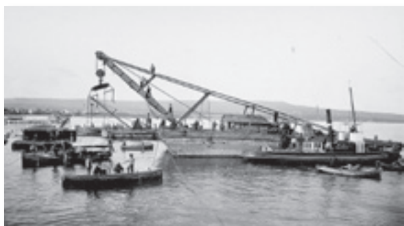
Момент от строителството на Пристанище Варна. На борд на плаващия кран „Напредък“ е застанал пристанищният влекач „Труд“, а вляво се виждат две водолазни лодки. Източник: Военноморски музей – Варна.
