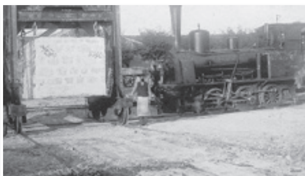
Момент от строителството на Пристанище Варна, 1905 г. Специално повдигателно устройство – бардър, повдига изкуствените блокове и ги натоварва върху жп вагони. Източник: Държавен архив – Варна.
