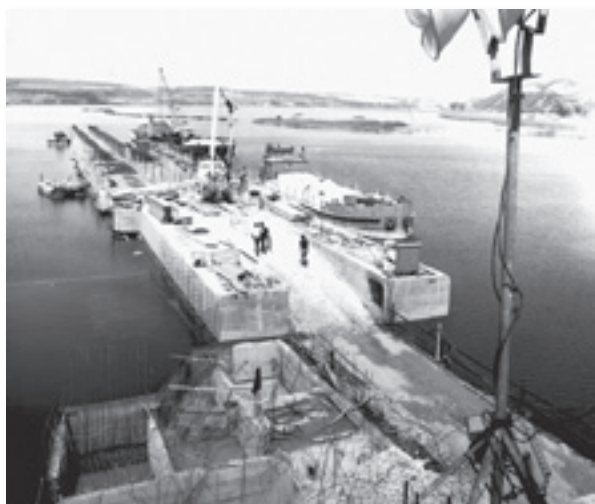
Момент от заключителния етап от строителството на Фериботния комплекс край Варна, поглед откъм брега, 1977 г. Източник: Дигитален архив на „Морски вестник“.
