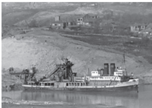
Удълбочаване на подхода към Пристанище Варна-запад пред село Страшимирово, 1972–1973 г. Източник: Дигитален архив на „Морски вестник“.
