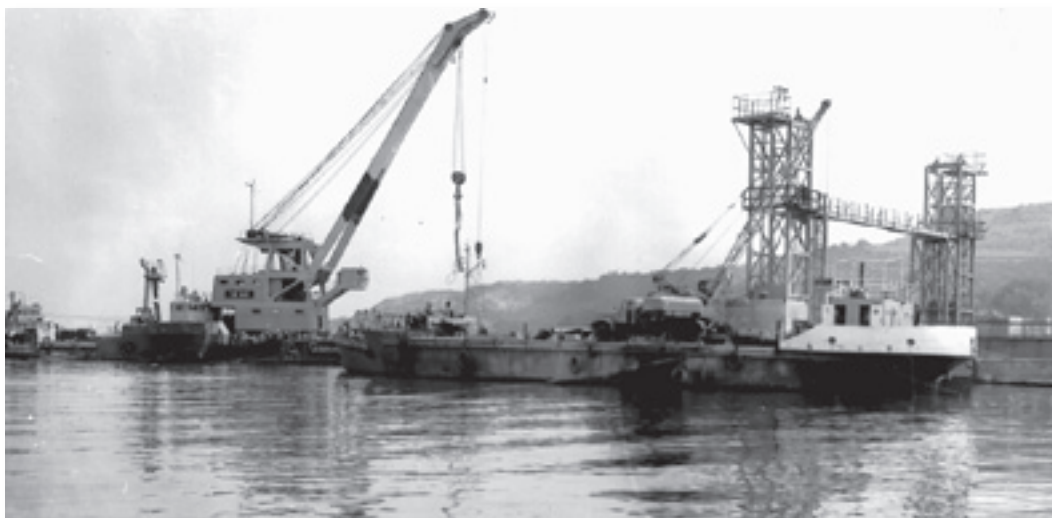
Момент от заключителния етап от строителството на Фериботния комплекс край Варна, 1977 г. Източник: Дигитален архив на „Морски вестник“.
