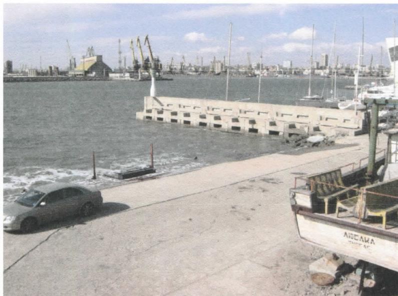
Фиг. 2. Противодифракционна „шпора“ на Бургаския вълнолом от модулни блокове HB
