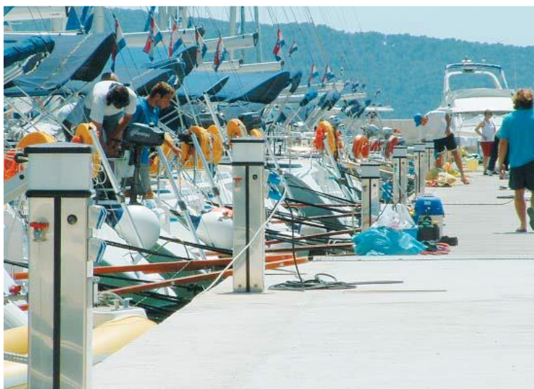
Фигура 29: Колонки за електро захранване и водоснабдяване
