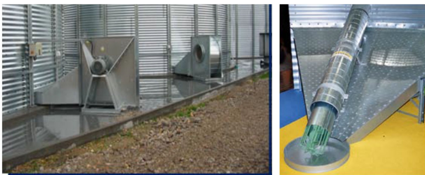
Фигура 10: Вентилационна система към силози
