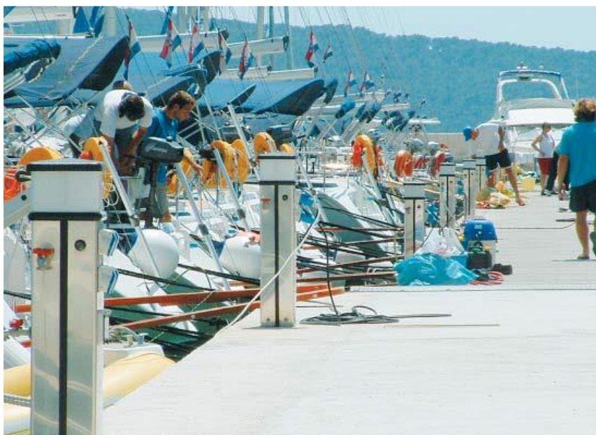
Фигура 35: Колонки за електро захранване и водоснабдяване
