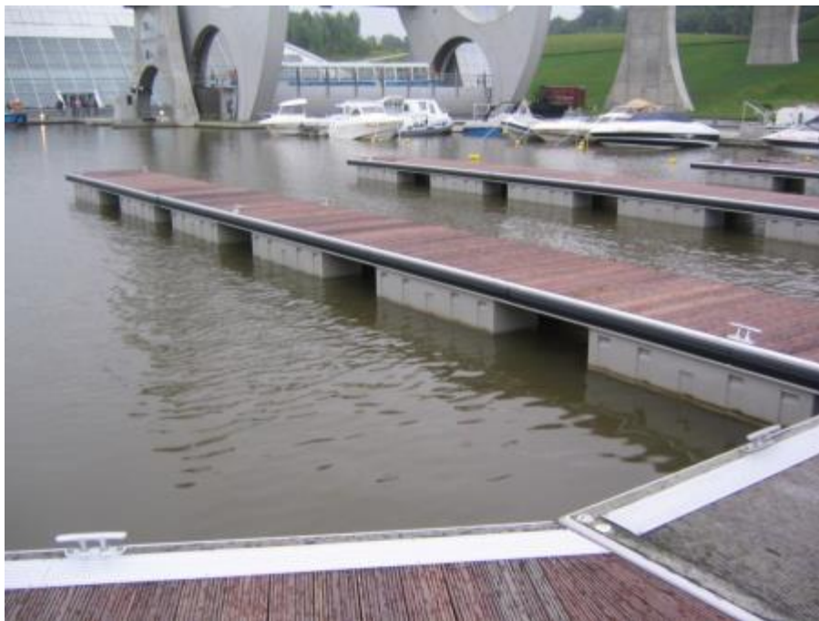
Фигура 36: Пример за плаваща понтонна система
